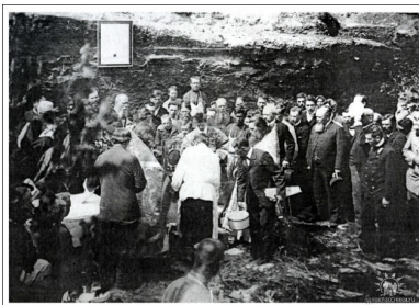
начало строительства церкви
